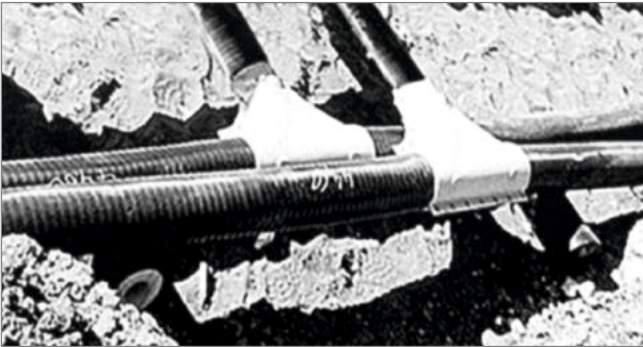
Рисунок 27. Пересечение теплосетей
